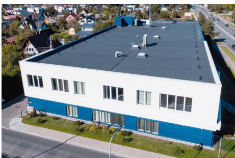
1 pav. Tyrimo metu analizuojamas pastatas
